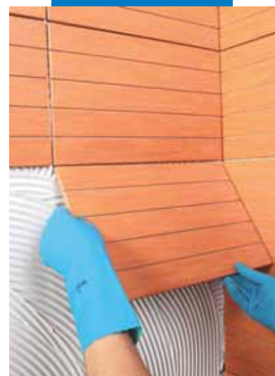
Aanbrengen van keramiek van boven naar beneden
