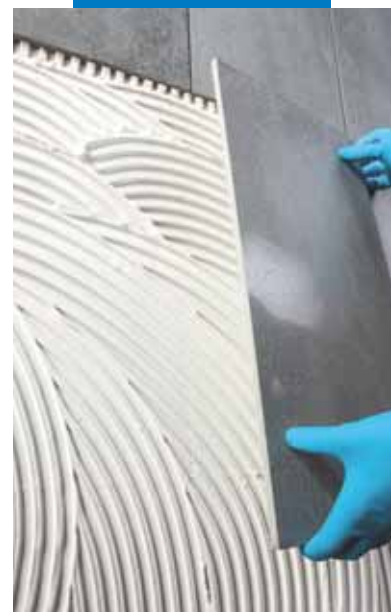
Aanbrengen van grootformaattegels op lichte betonblokken
