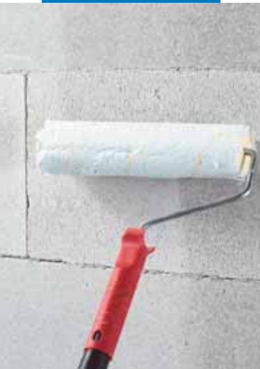
Het voorstrijkmiddel aanbrengen op de ondergrond van lichte betonblokken
