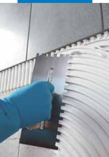
Ultramastic 5 op de ondergrond aanbrengen
