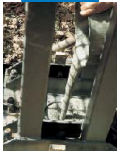
Het gieten van Mapefill
