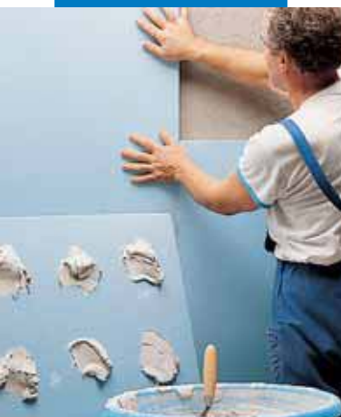
Aanbrengen van polystyreenplaten met Keraflex wit
