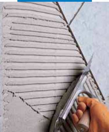
Betegelen van wanden in cellenbetonblokken
