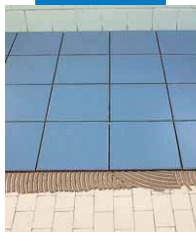
Betegelen met keramische tegels van bestaand keramisch tegelwerk met Keraflex grijs
