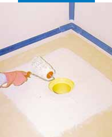
Voltooid waterdichting met Mapegum WPS en Mapeband
